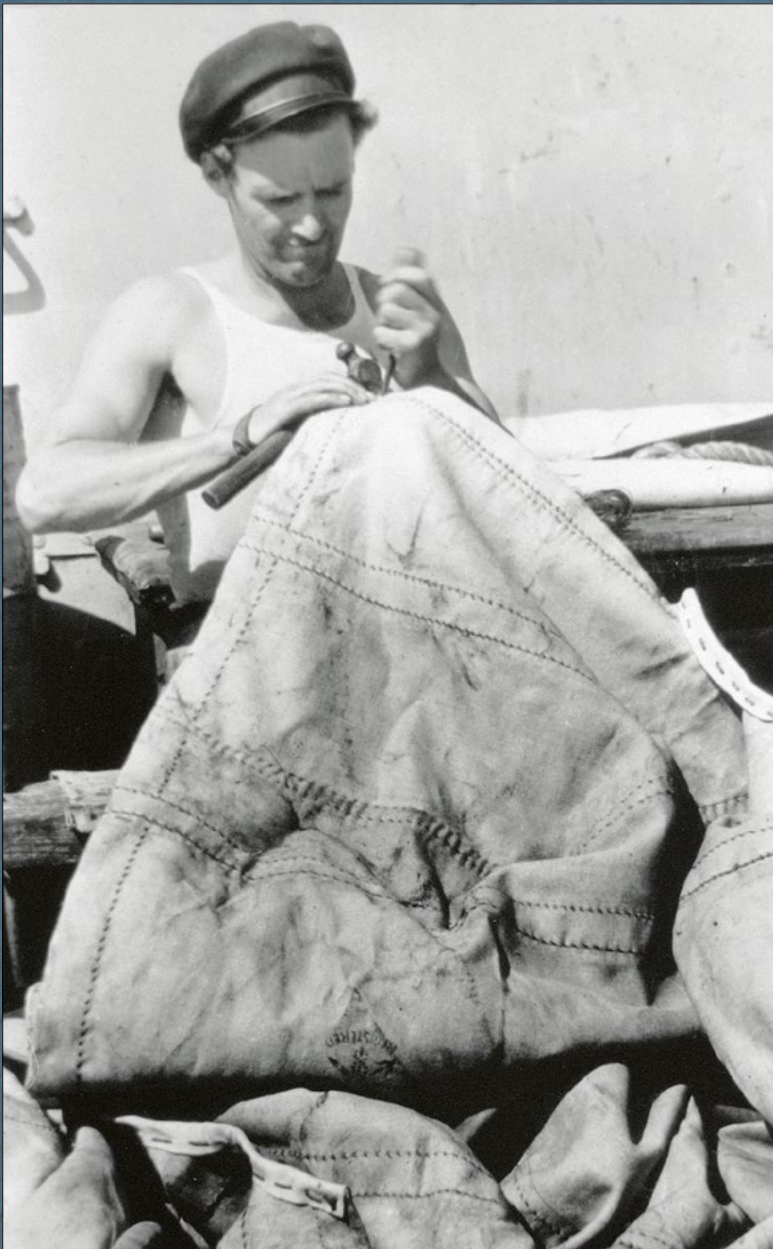
Segellappning på däck. I det gynnsamma vädret i passaderna hade man mer tid för underhållsarbete.
