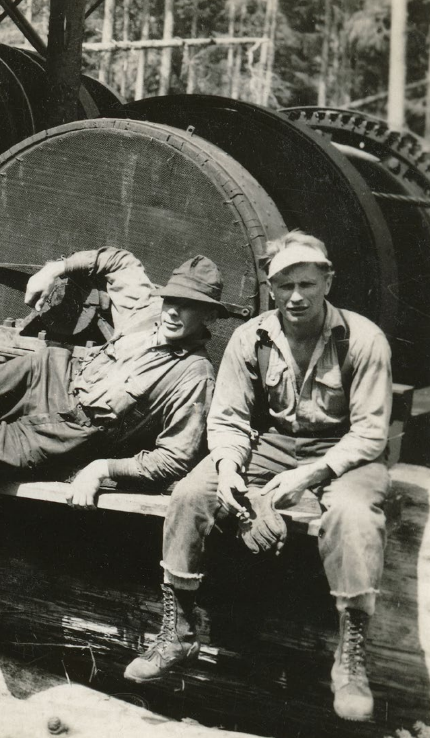
Edvin Eklund med sina arbetskamrater vid en så kallad steam donkey , en ångdriven vinsch som användes för att dra ut timmer ur skogen.
